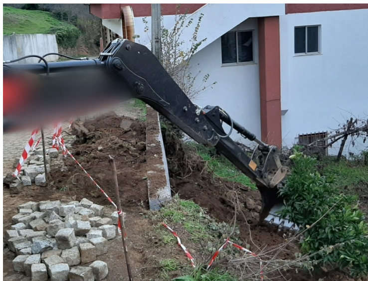
Construção de muro de sustentação de terras
