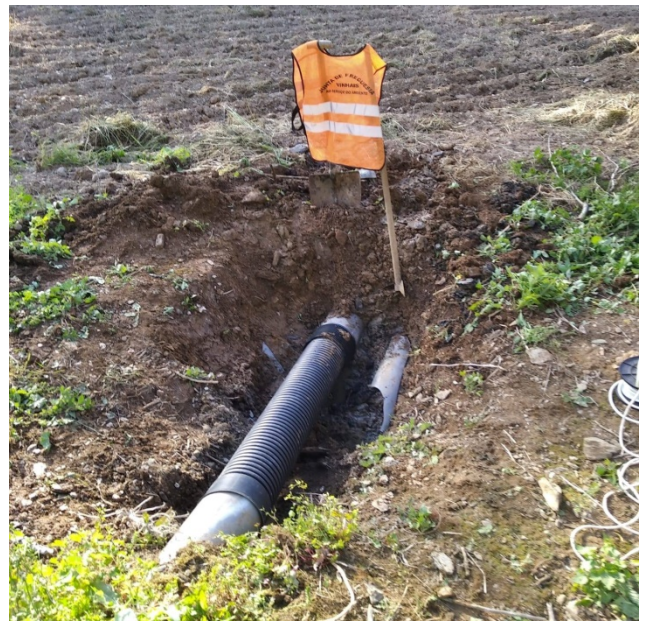
(“antes”) Arranjo de conduta - águas pluviais (“depois”)
