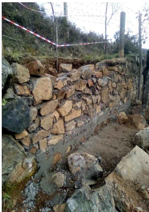
Construção de muro de sustentação de terras (“Santo António”)
