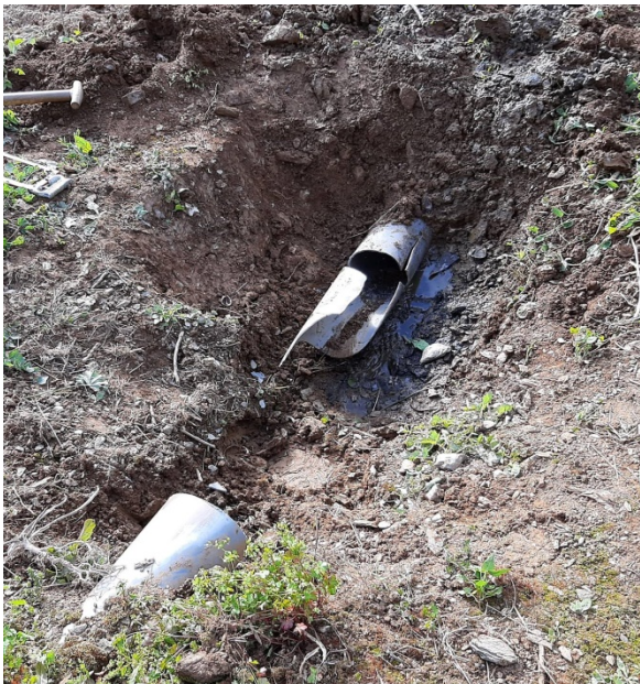
(“antes”) Arranjo de conduta - águas pluviais (“depois”)
