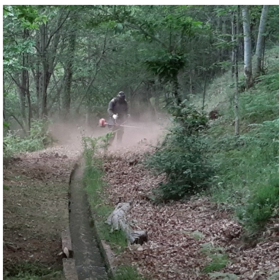
Limpeza / manutenção de canal de regadio
