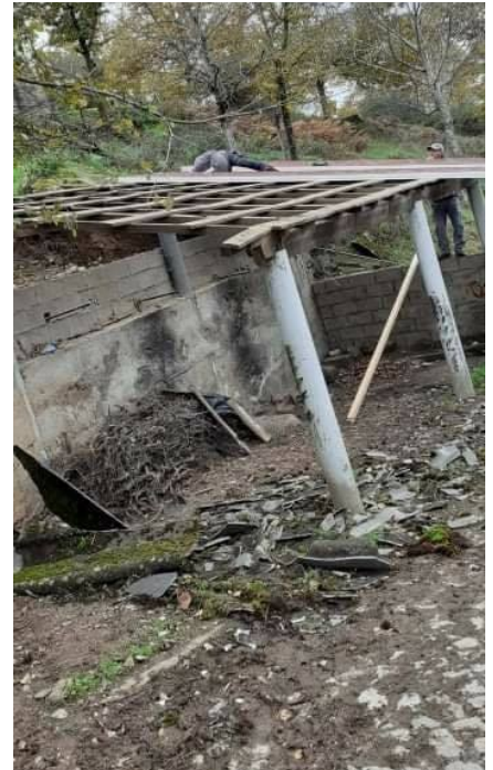
Requalificação de espaço comunitário
