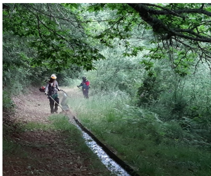
Limpeza / manutenção de canal de regadio
