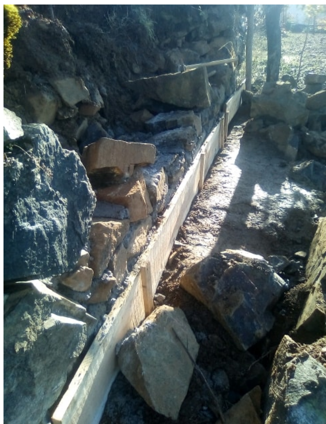
Construção de muro de sustentação de terras (“Santo António”)
