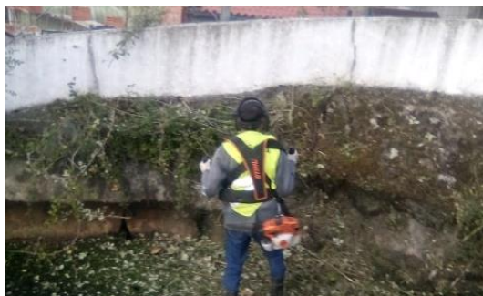
Limpeza de tanque
