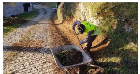
Limpeza de valetas na aldeia
