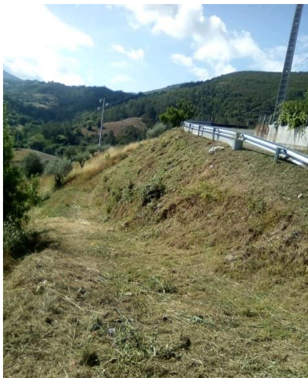
Limpeza de ruas/estrada municipal
