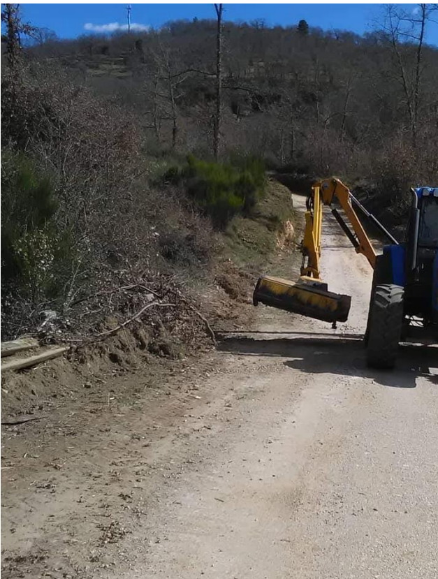
Limpeza de caminhos rurais
