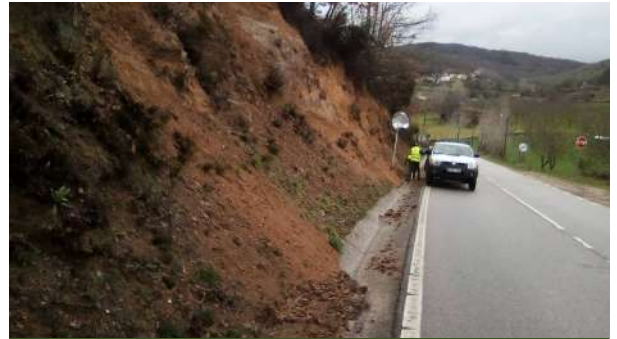
Limpeza de valetas
