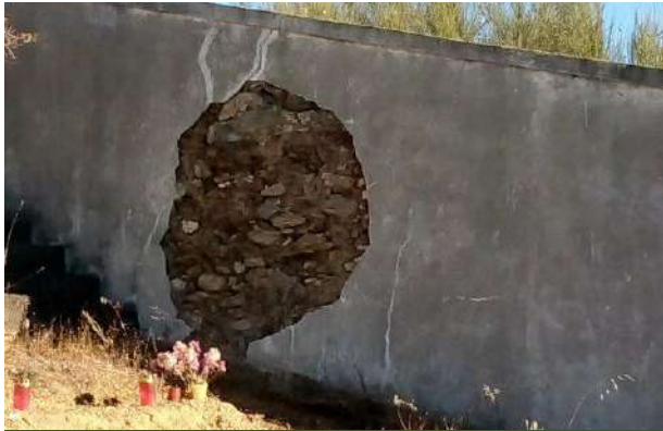
Requalificação do Cemitério (“antes”)
