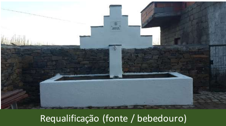
Requalificação (fonte / bebedouro)
