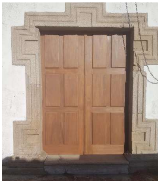
Renovação de portas da Igreja (frontal – “depois”)
