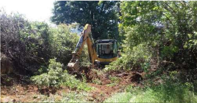
Limpeza de caminhos rurais
